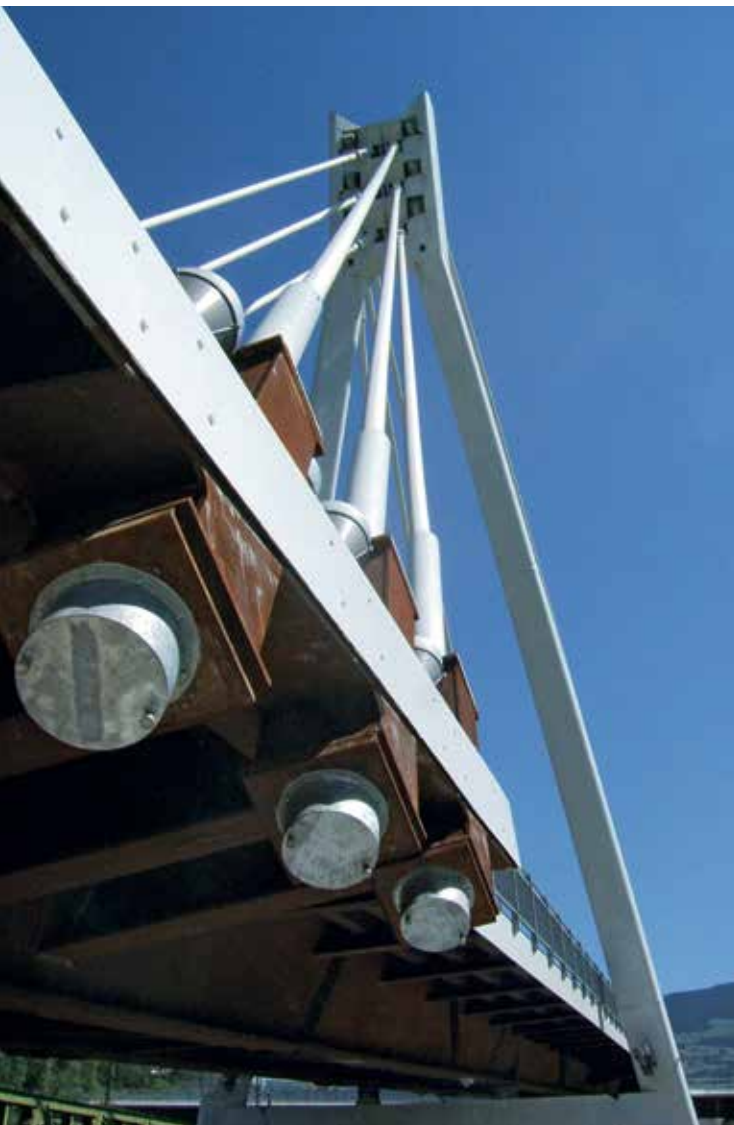
Puente atirantado en Alves, Bressanone (Italia)
