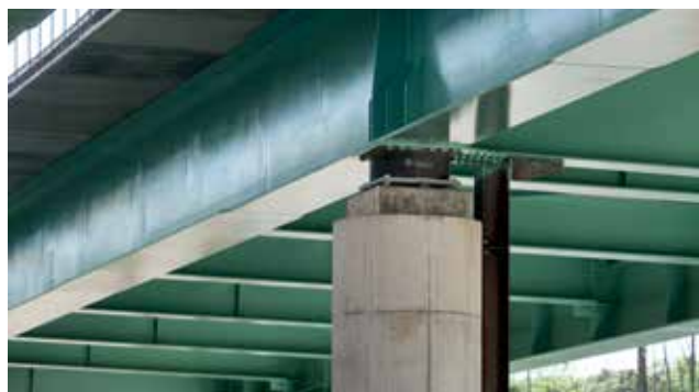
Autopista Pedemontana, viaducto del Lura (Italia)
